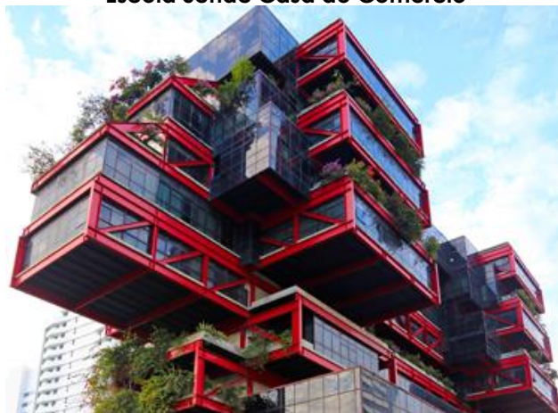
Figura 1. Imagem das instalações do Restaurante-Escola Senac Casa do Comércio
